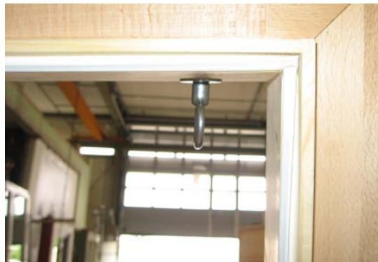
Bild 4 Falzdichtung im Lukenkasten
