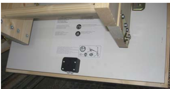
Bild 3 Deckelaufbau und -verriegelung
