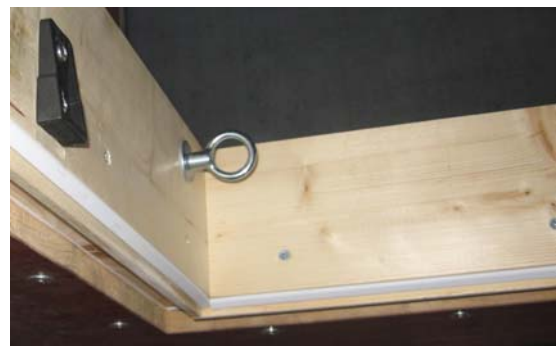
Bild 4 Falzdichtung im Lukenkasten
