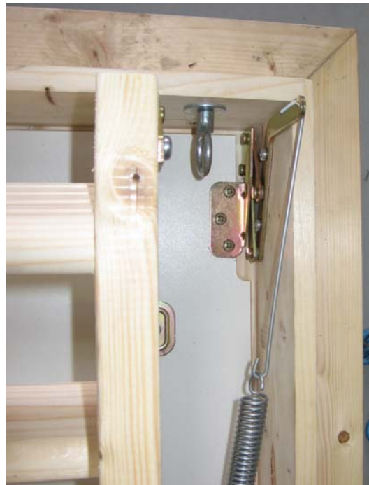
Bild 2 Bandausführung mit Federsystem
